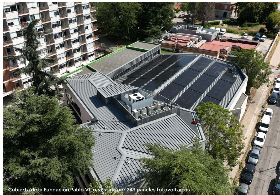
Cubierta de la Fundación Pablo VI revestida por 243 paneles fotovoltaicos
