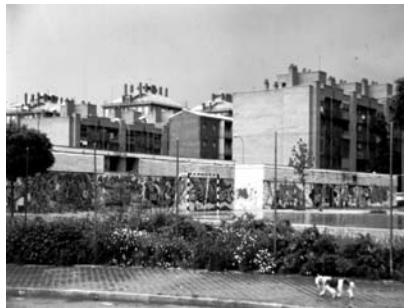
Figura 7. Deterioro de los espacios en Orcasur
