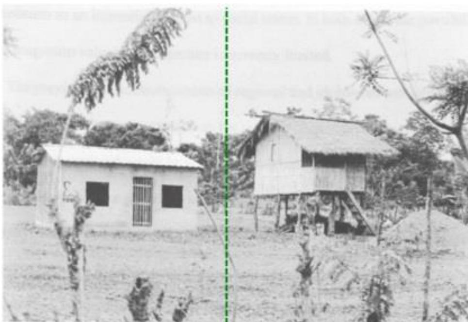
Fig. 03: Imagen de una vivienda construida con bloque de hormigón y una vivienda vernácula manabita.
